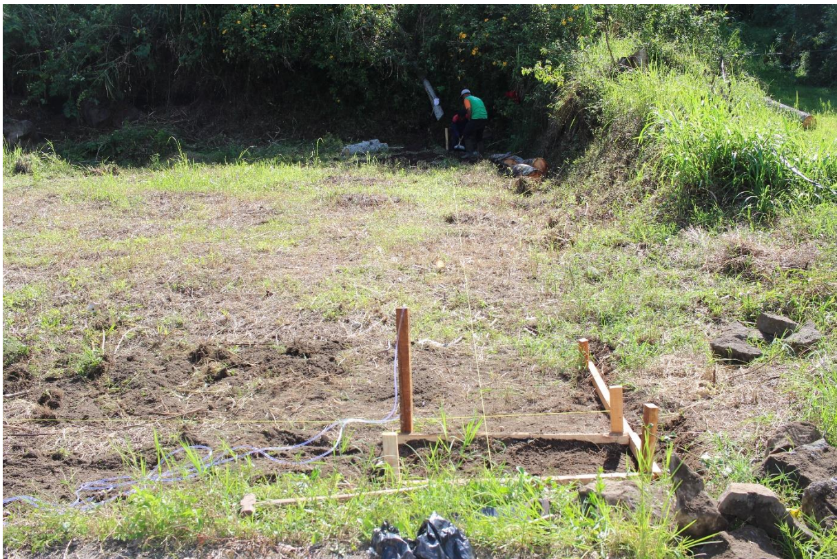
De grondlijnen voor het volièrecomplex worden uitgezet
